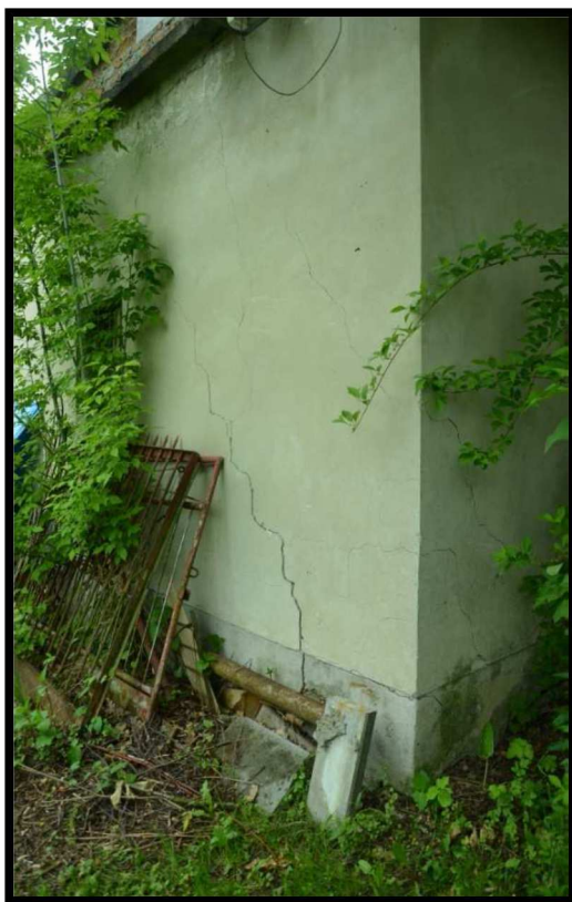
Fotografia 2. Pękający budynek w pobliżu otworu I16-009-0913 (fot. Marta Chada)
