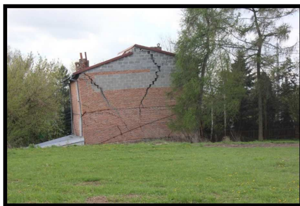
Fotografie 3 i 4. Pękający budynek w pobliżu otworu I16-002-0011 (fot. Marta Chada)
