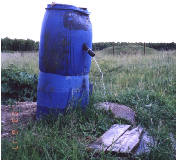
Ryc.7. Studnia publiczna zaopatrująca w wodę nieliczne gospodarstwa (Woda czerpana jest wiadrami po otwarciu zaworu zamontowanego w górnej partii beczki)
