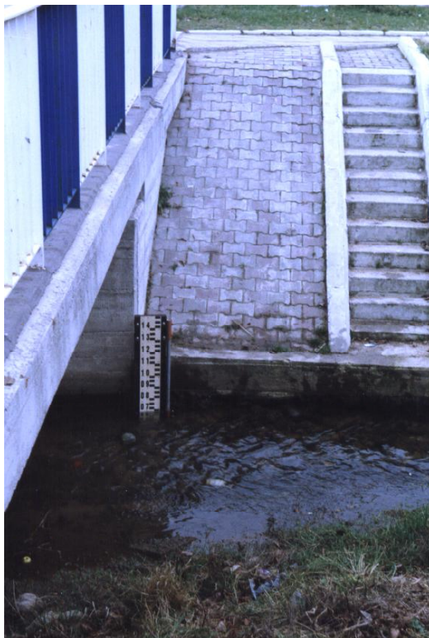
Ryc.17. Wodowskaz na rzece Krynce w przekroju hydrometrycznym – most przy ulicy Garbarskiej. Rzędna górnej krawędzi wodowskazu 140,8 m npm. Widoczne - wąskie koryto rzeki i małe jej wypełnienie
