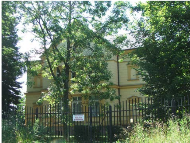
Pałac w Bobrownikach
