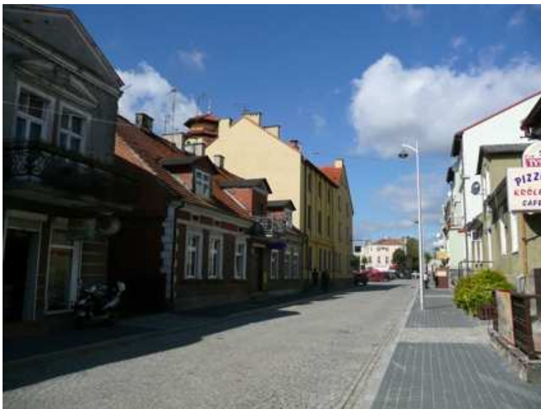
Fot. 8. Zabytkowe kamienice przy ul. Michała Kajki.
