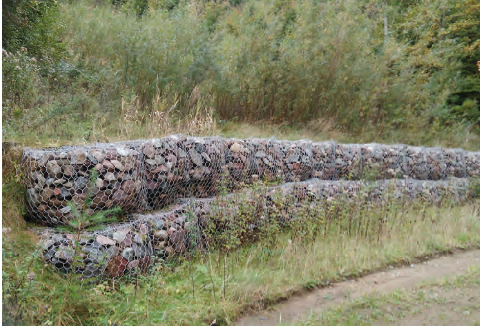
Fot. 1. Osuwisko w pobliżu zbiornika Czymanowo, widok na koluwia i jeźor osuwiska umocniony gabionami (fot. A. Malka, 2019)
