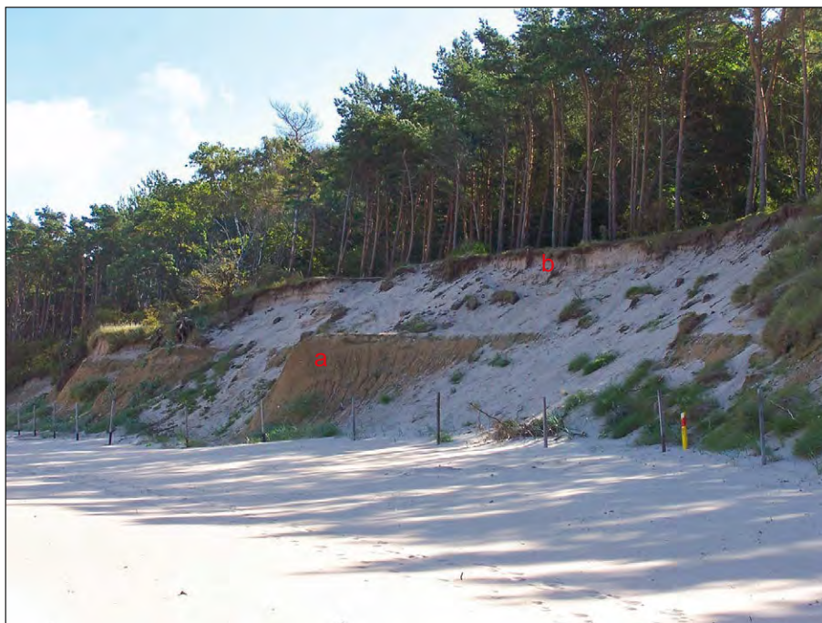
Fig. 4. Gliny zwałowe stadiału górnego zlodowacenia Wisły (a) i zalegające na nich piaski eoliczne (b) w miejscowości Pustkowo (ark. Kamień Pomorski) (376 kmM); wysokość skarpy około 7 m
